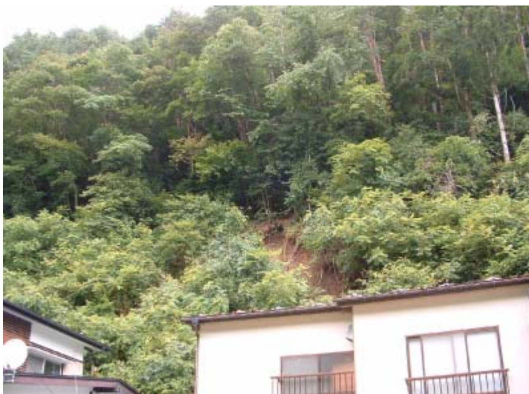
写真 - 8 北上町舘取地区で発生した粘板岩分布域の表層崩壊（図 - 1 中の 9 の箇所）
