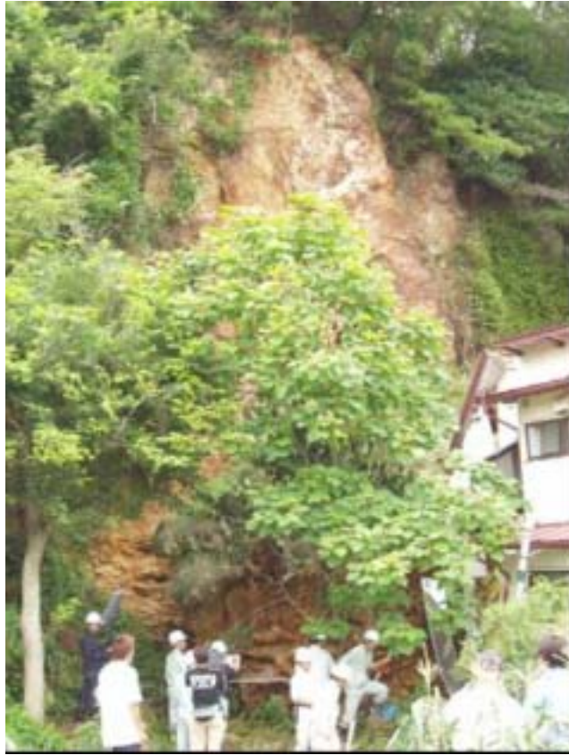
写真 - 1 鳴瀬町北赤碕地区で発生した凝灰角礫岩分布域の落石と家屋への被害（図 - 1 中の 1 の箇所）
