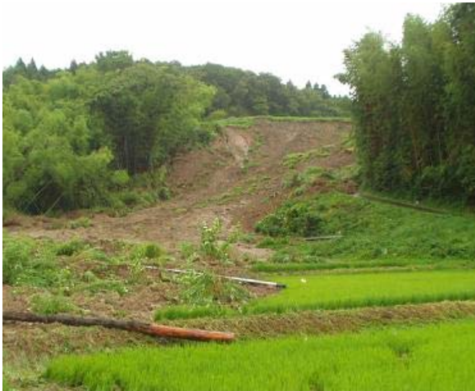
写真 - 4 河南町北村地区で発生した崩壊性地すべり（図 - 1 中の 6 の箇所）
