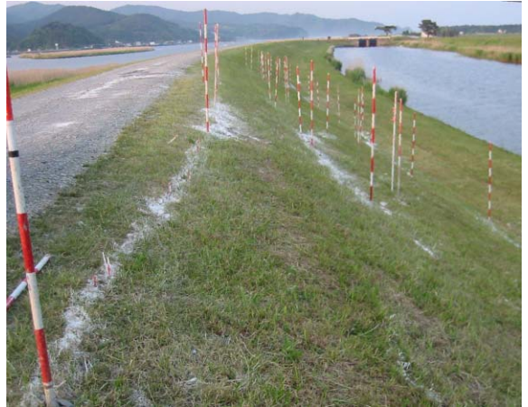
口絵写真 - 2 北上川釜谷地区堤防(1.3km付近)の被災状況。白線は、地震により発生したクラックに石灰を注入したもの。(撮影:北上川下流河川事務所)
