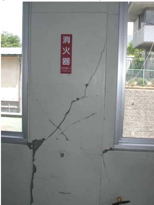
口絵写真 - 3 RC3階建校舎の北面の被害
