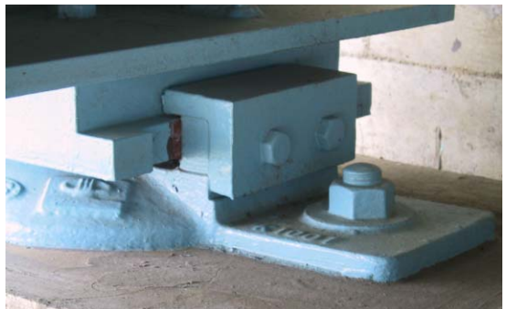
写真-1 支承部のこすれ跡の一例(国道45号気仙大橋、岩手県陸前高田市、温度変化の影響の可能性もあり)
