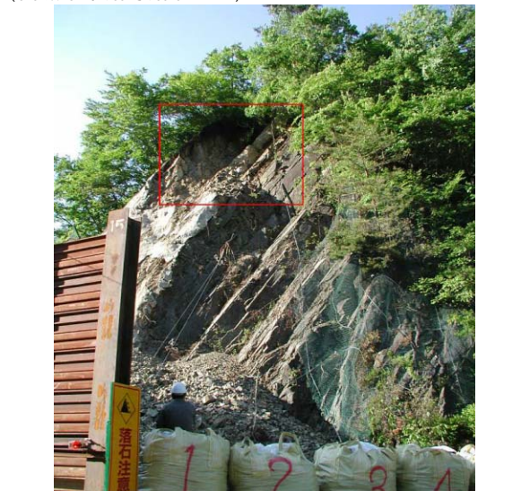
口絵写真 - 11 瀬田米子飼沢(岩手県住田町)で発生した剥離型落石
