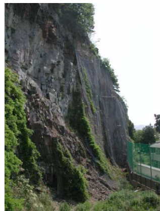
写真 - 2 鹿妻地区(宮城県石巻市)剝離型落石
