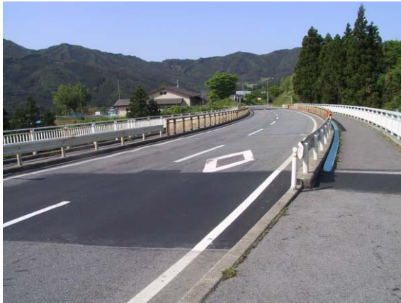
口絵写真 - 7 国道45号白木沢橋 (岩手県大船渡市、橋台取付け盛土の沈下、アスファルト盛付けによる補修状況)
