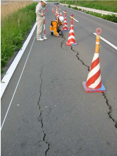
口絵写真 - 1 北上川七尾(11.5km付近)の被災状況。堤防天端に縦断クラックが発生した。(撮影:北上川下流河川事務所)
