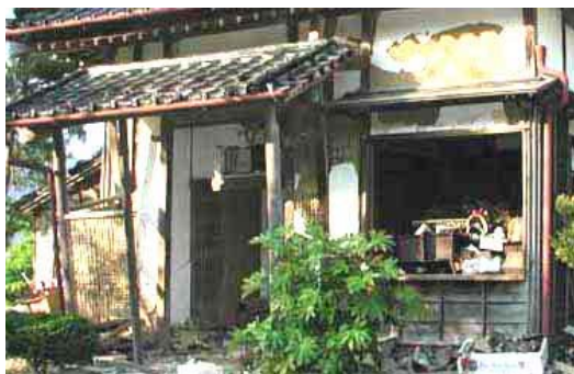
写真 - 3 在来木造の被害
