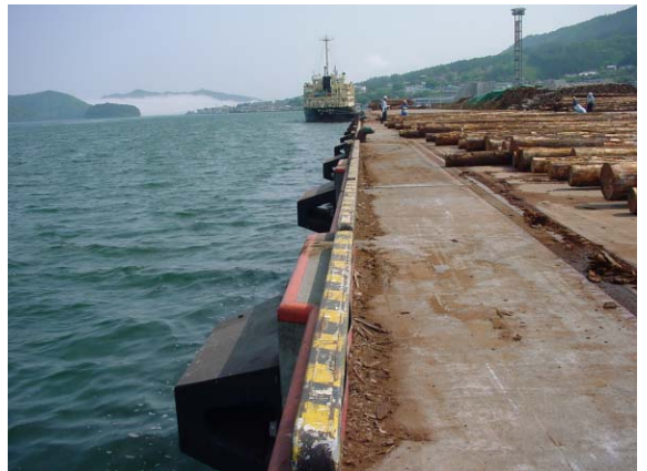
口絵写真 - 5 野々田地区-13m岸壁の状況
