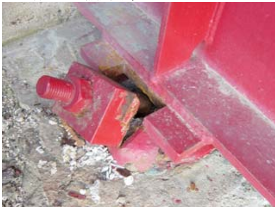
口絵写真 - 8 線支承のアンカーボルトの橋軸直角方向への変形状況(船渡橋、橋台部)
