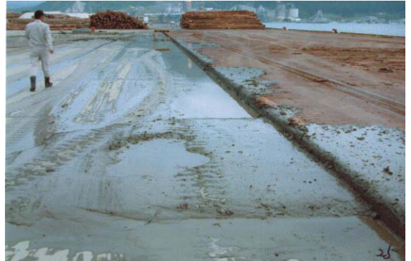
口絵写真 - 4 野々田地区-13m岸壁直背後 シルトの堆積状況
