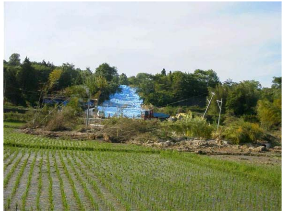
口絵写真 - 10 館下地区で発生した地すべり (宮城県築館町館下地区)
