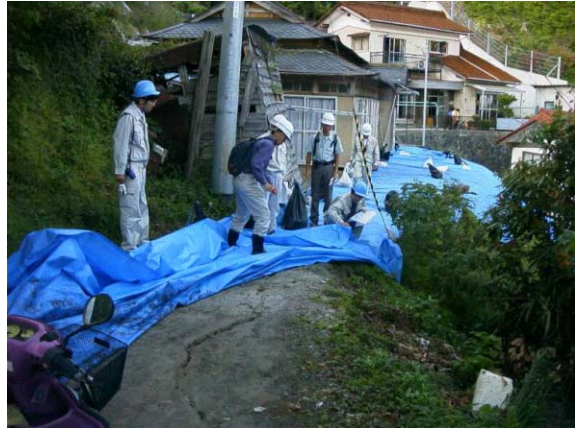
口絵写真 - 9 のり肩への亀裂の発生 (宮城県牡鹿町前浜地区)
