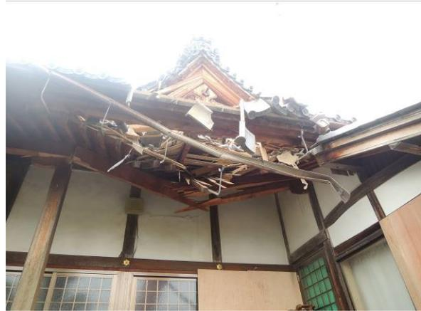
写真 13 鋼製屋根が衝突した範囲の状況
