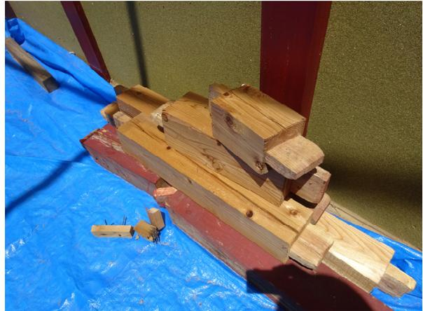
写真3 飛散した屋根の小屋束
