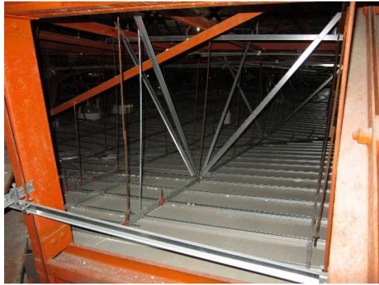
写真5-22 天井裏（鋼製下地材による天井）
