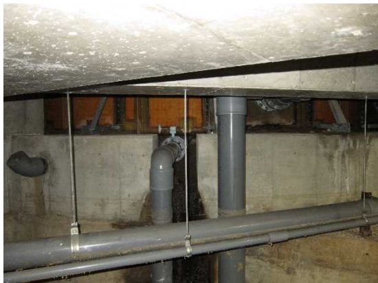
写真5-78 流水プールの床下の様子
