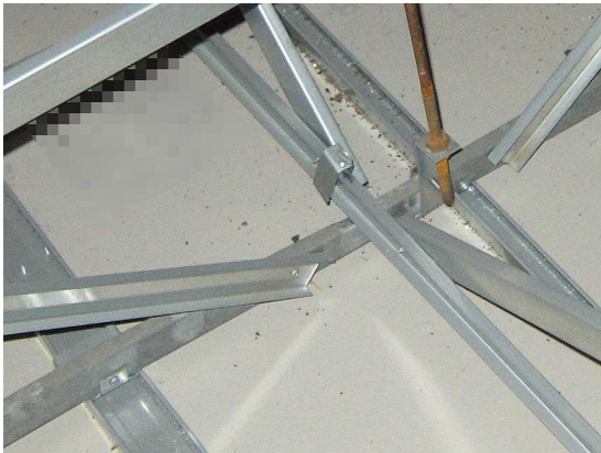
写真5-23 ねじどめした接合部の詳細
