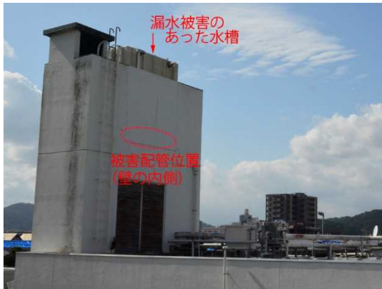
写真 5-27 別棟の高架水槽外観
