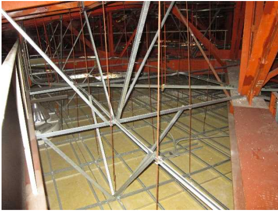
写真5-21 天井裏（システム天井）
