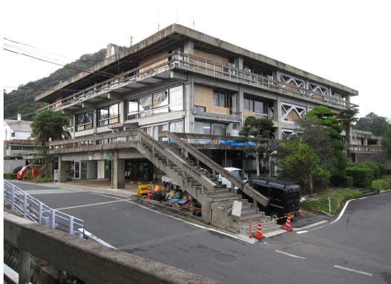
写真5-40 外観（北東から見る）
