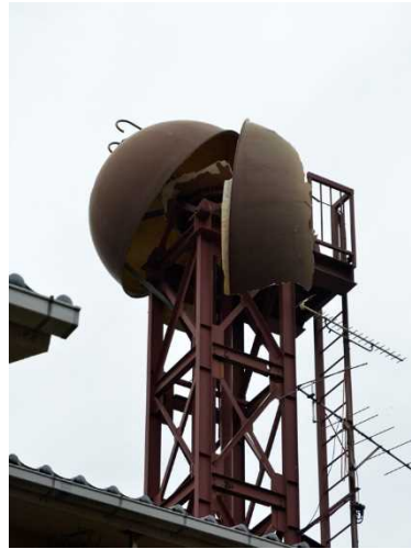
写真 6-7 FRP 製の高架水槽の破壊
