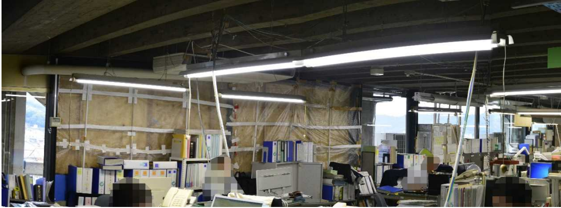
写真5-44 庁舎内部の状況（パノラマ合成）
