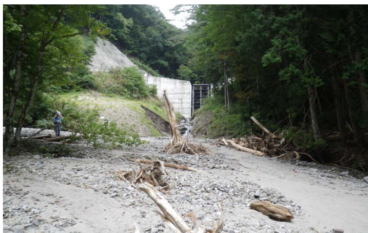
写真. 32 不透過型砂防堰堤遠景
