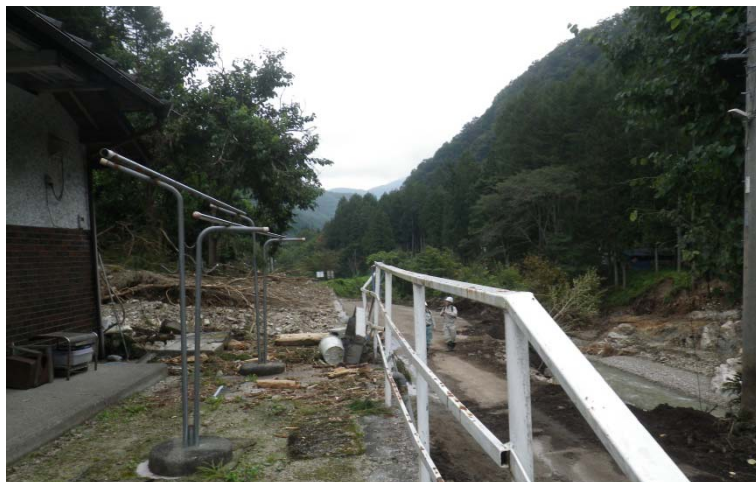
写真. 24 対岸の溪岸侵食の状況
