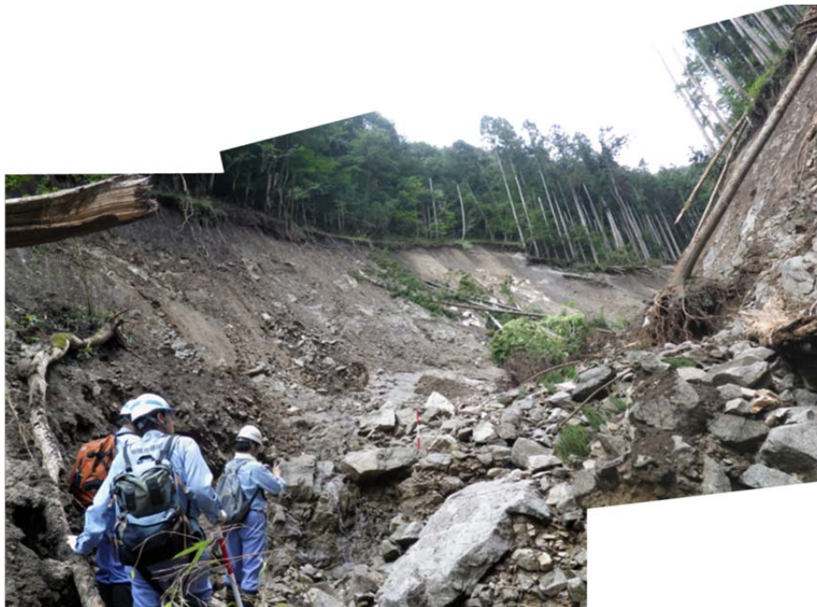
写真. 21 溪床が低下した状況
