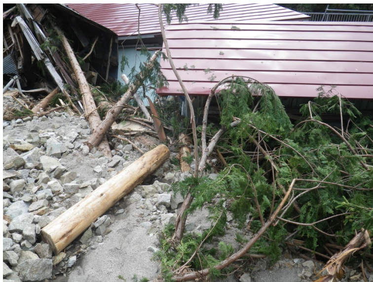
写真. 12 半壊家屋上流側の土砂や流木の堆積状況
