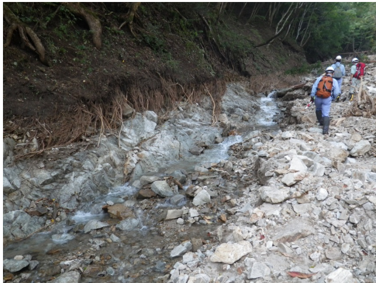
写真. 14 基岩の露出と表土の流出状況
