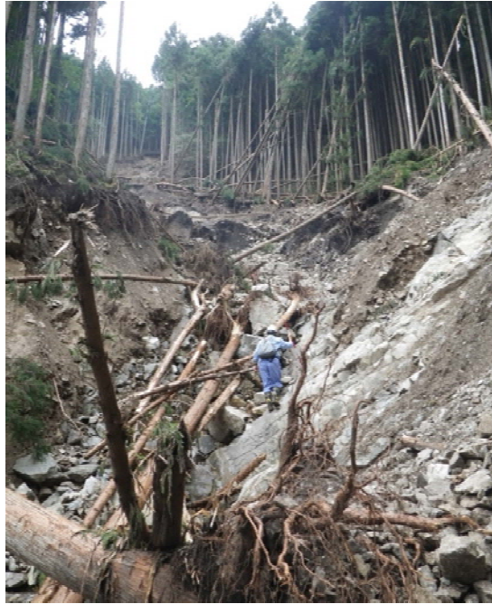
写真. 6 土砂発生源付近の状況
