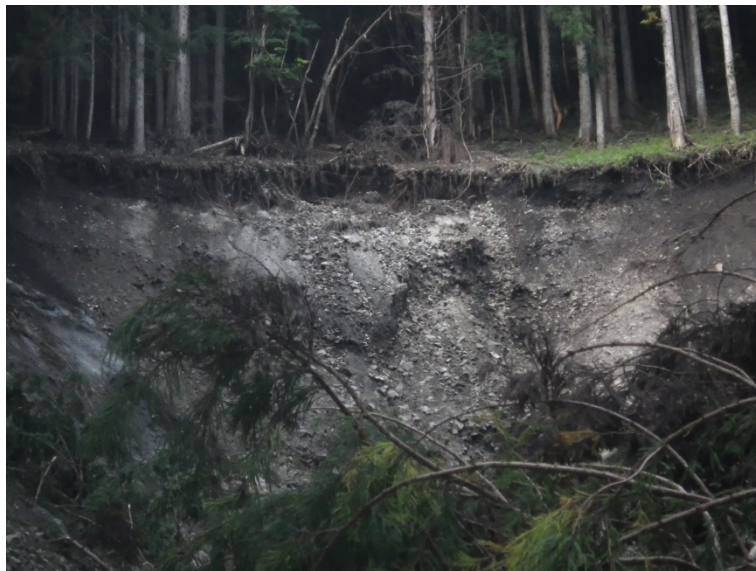
写真. 8 土砂発生源の状況
