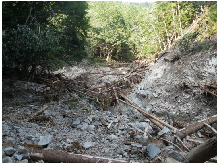
写真. 13 溪流内の流木堆積状況
