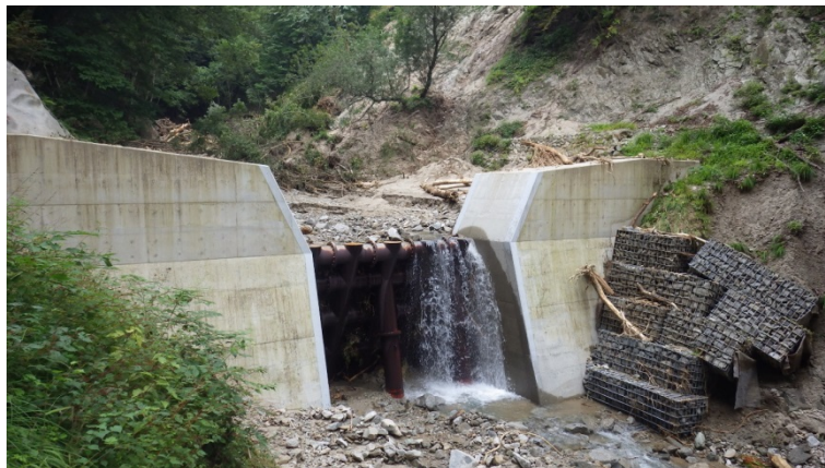
写真. 31 不透過型砂防堰堤の効果
