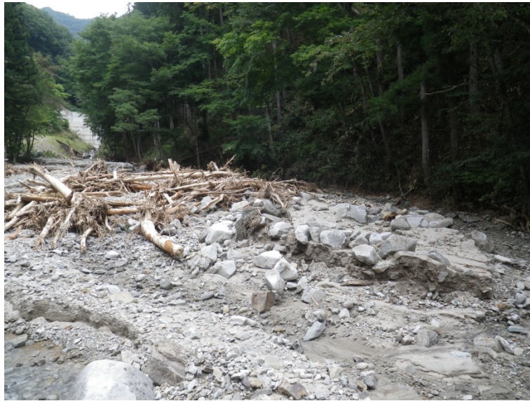
写真. 33 不透過型堰堤堆砂敷への土砂堆積状況
