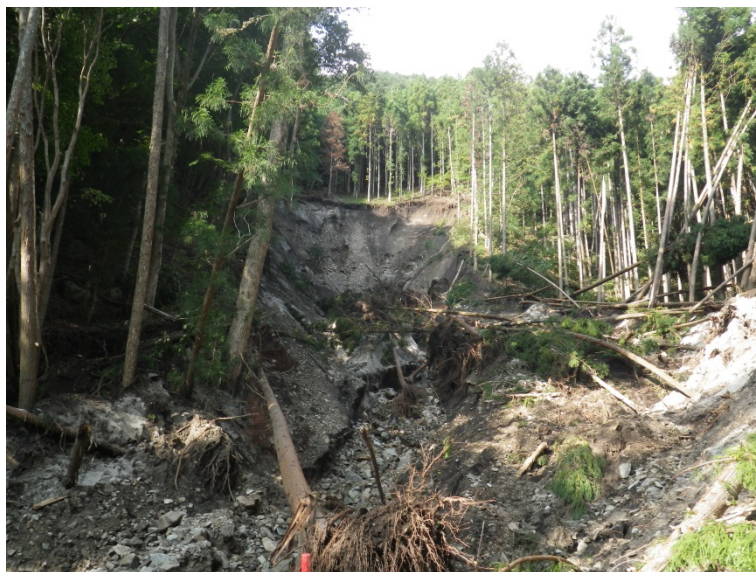
写真. 9 土砂発生源直下の侵食状況
