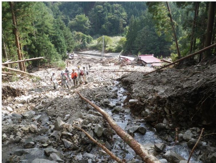
写真. 11 溪流出口付近の土砂堆積状況
