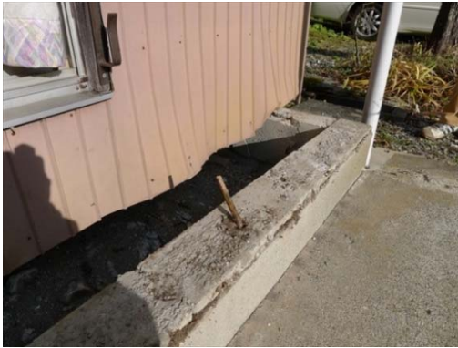
写真 5.3.19 確認されたアンカーボルト
