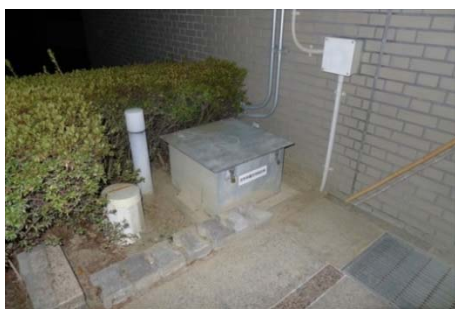
写真 6.2.3 小川村震度計設置状況
