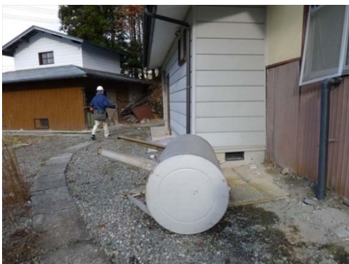
写真 5.3.24 灯油タンクの転倒
