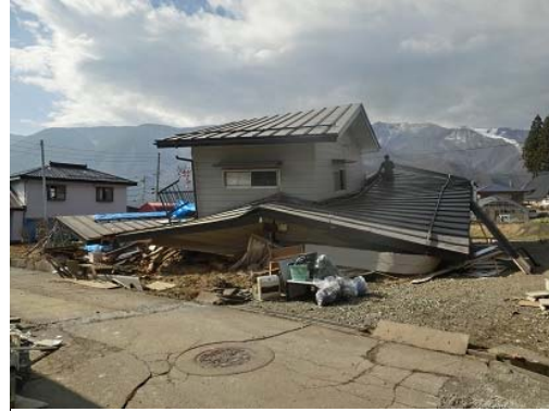
写真 5.1.15 倒壊した住宅
