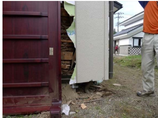
写真 5.3.9 壁の著しいずれ
