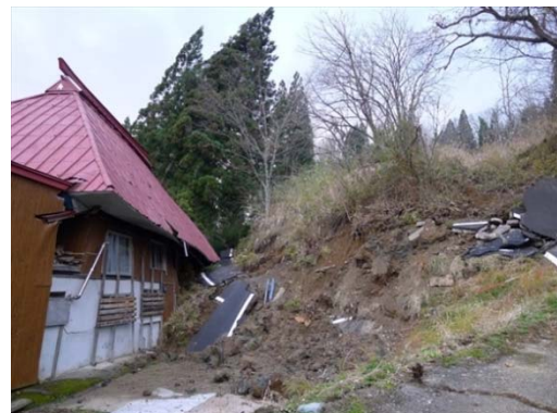
写真 6.1.2 建築物背面の土砂崩れ
