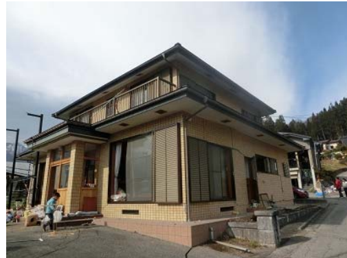
写真 5.1.19 被害が軽微な住宅
