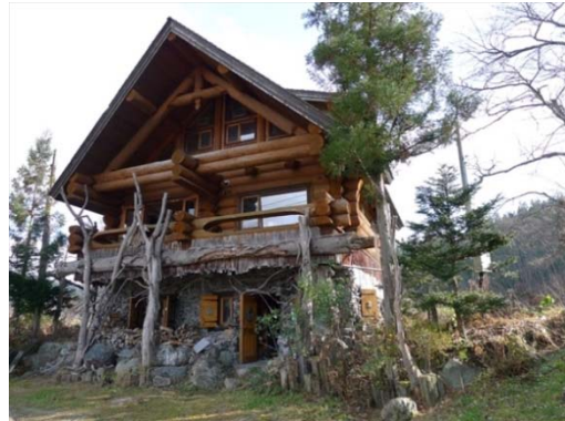
写真 5.3.21 1F RC+2階ログハウスの建築物
