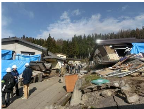
写真 5.1.2 堀之内西部の倒壊した住宅
