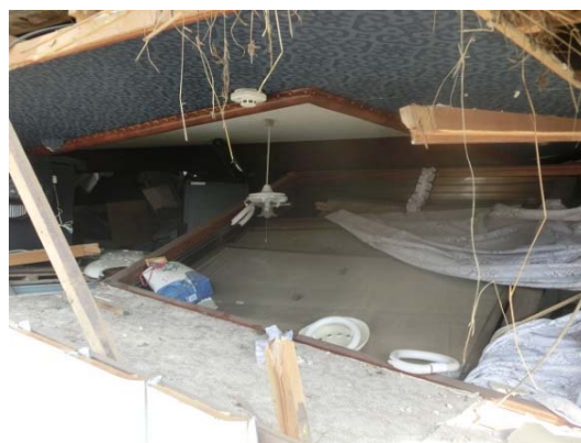
写真 5.1.11 1 階に生じた空間
