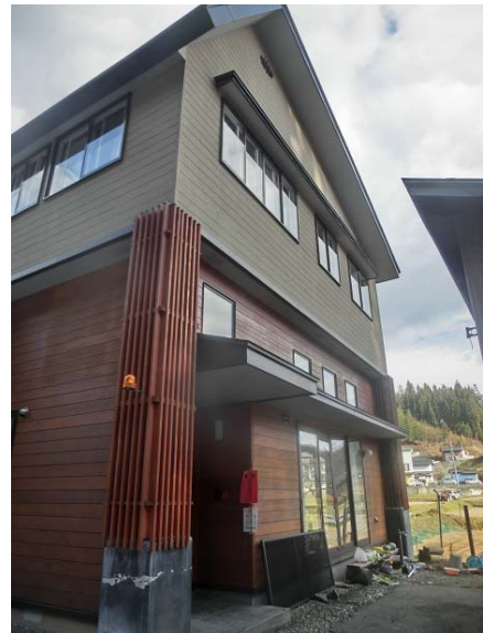
写真 5.2.2 1 階部分に鋼管がある住宅
