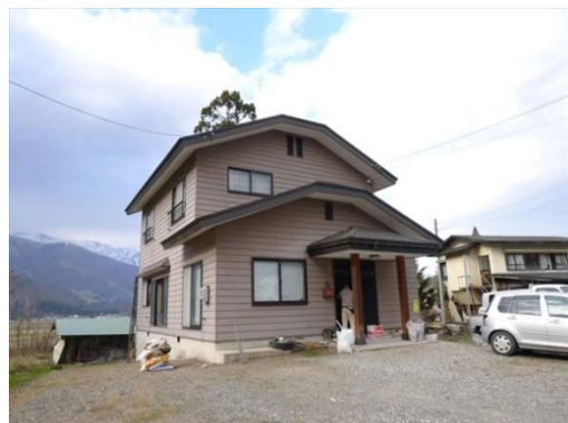
写真 5.3.25 外観からは被害が少ない住宅
