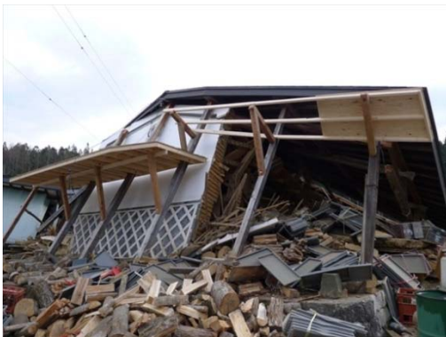
写真 5.3.22 倒壊した土蔵
