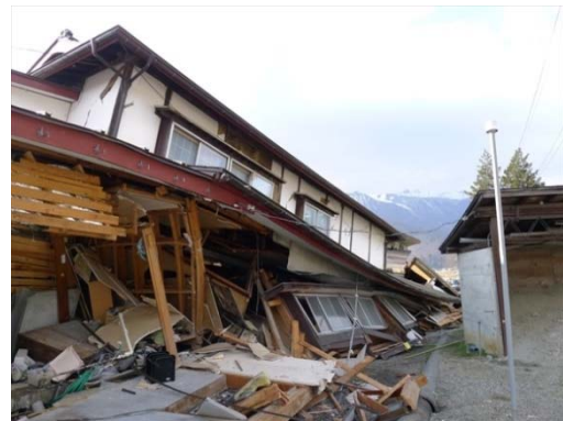
写真 5.3.2 既存部の母屋の倒壊
