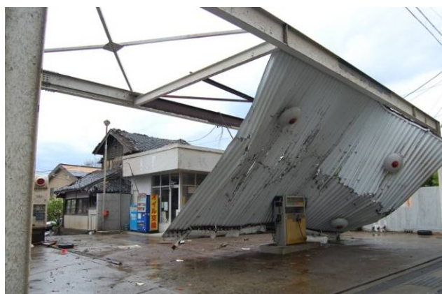
写真 30 ガソリンスタンドの折板屋根の脱落
