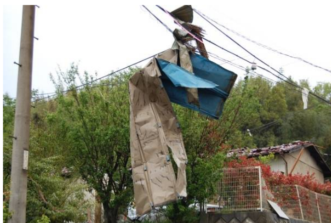
写真 29 電線に引っ掛かった飛来物(鋼板製屋根材)
