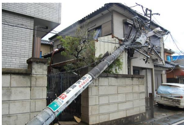
写真 34 電柱の折損・傾斜 2
