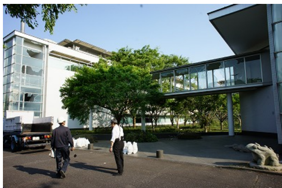
写真 38 渡り廊下のガラスの損傷
