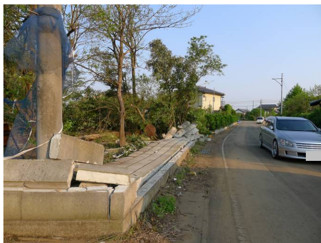
写真 32 石塀の倒壊
