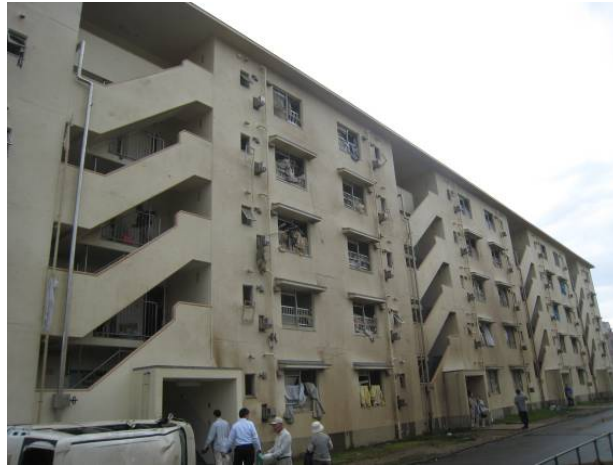
写真 24 集合住宅の北面の状況
