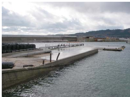
(3) 鋼製の仮設栈橋（写真中ではふ頭の奥側）
