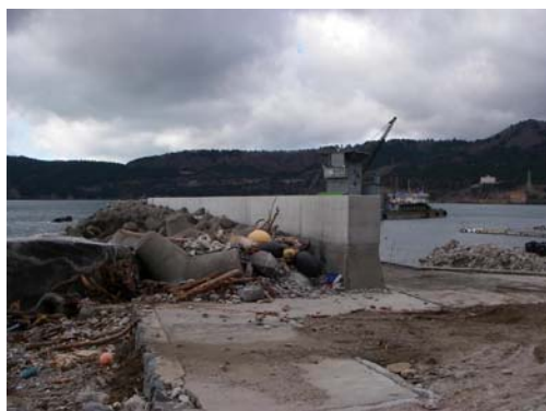
(1) 護岸（左側が港外側，右側が港内側）
