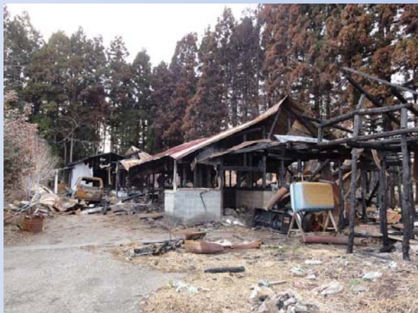
奥州市：住宅(納屋併用)火災
