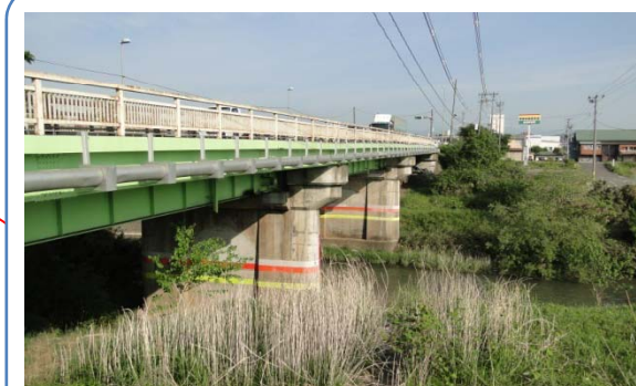
単純鋼鉄桁橋 (3連)
