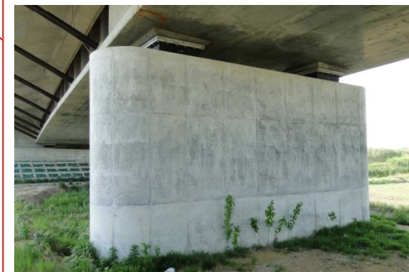
5径間連続PC箱桁橋
