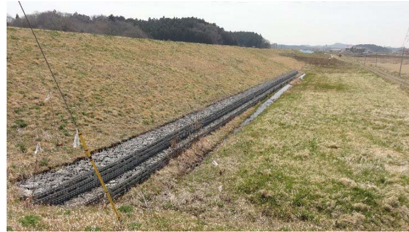
裏のりの状況 (4/15)
