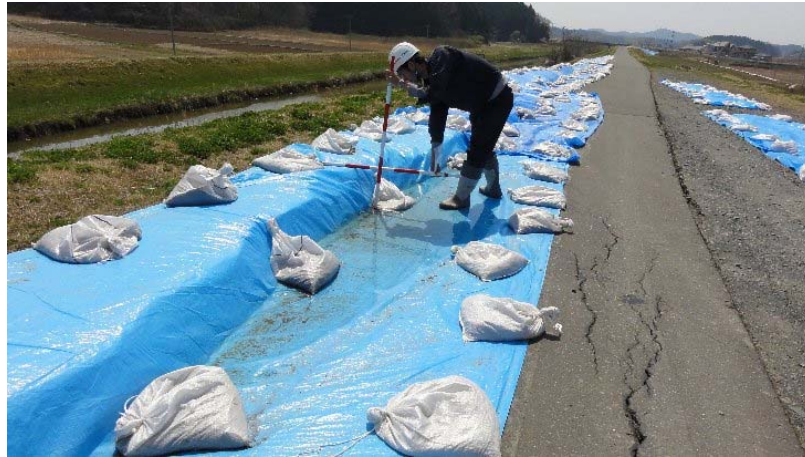
天端の縦断亀裂および段差 (4/15)
