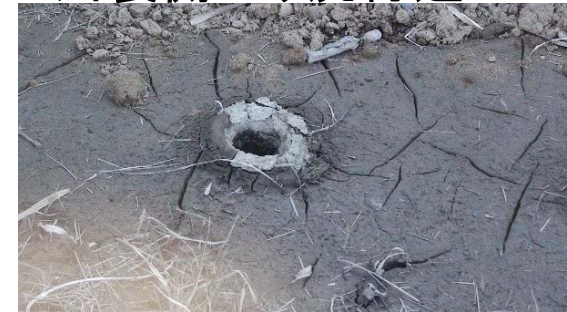
堤体の亀裂内の 噴砂
