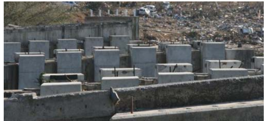
損傷痕跡のない変位制限構造 (アンカーバーは、ほぼ真直ぐの状態)
