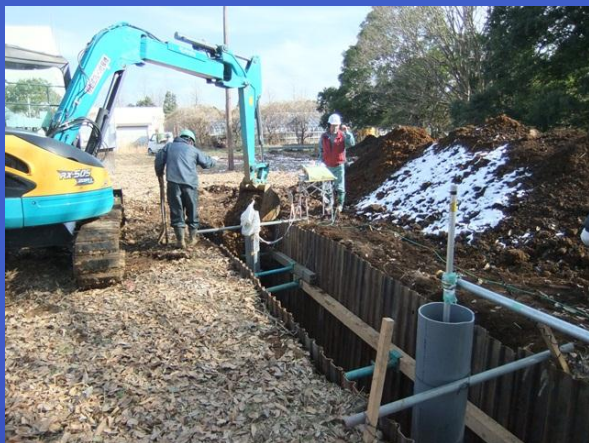
試験施工の状況
