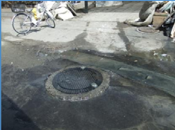
マンホールからの下水の溢水
