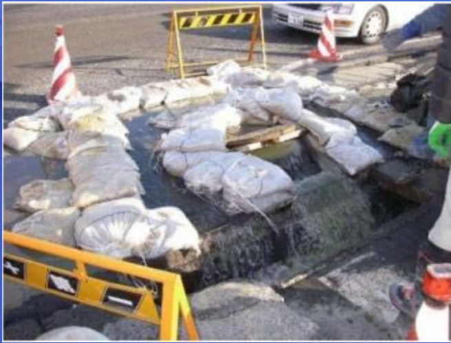
①土のう仮設水路
