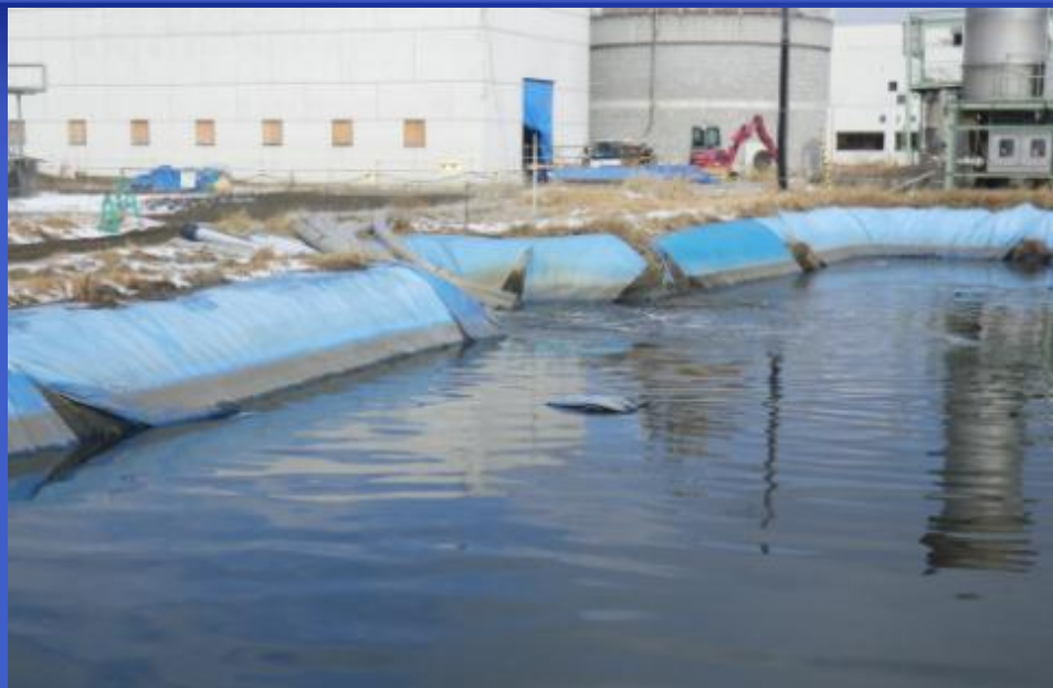
素堀による仮設沈殿池の設置
