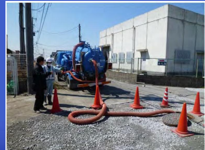
④バキューム車吸引 （下水処理場で処理）
