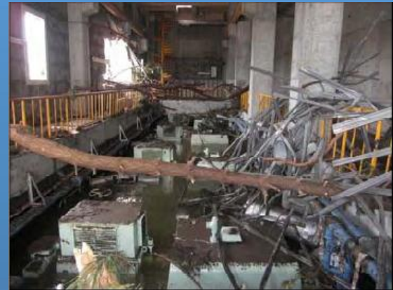
下水処理場の被災
