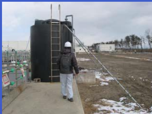
次亜塩素酸ナトリウムの の備蓄タンク
