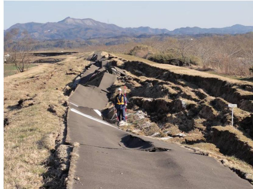
堤体の液状化による堤防の被災状況(阿武隈川)
