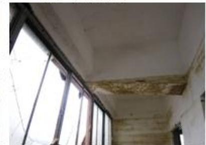
写真4 建物1階の浸水痕
