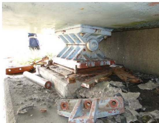
可動支承部の損傷
