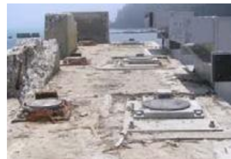
流出した上部構造の断面形状と破損した支承構造
