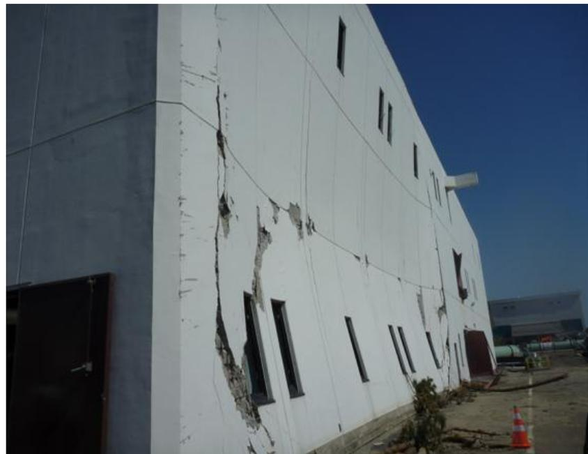
津波の衝撃で破壊したポンプ棟
