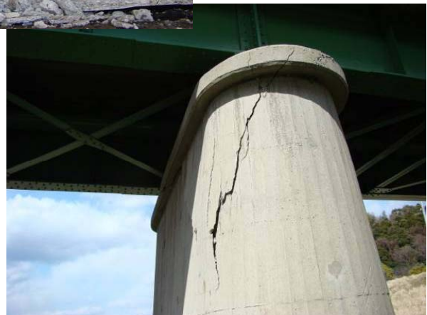
橋脚天端付近の損傷
