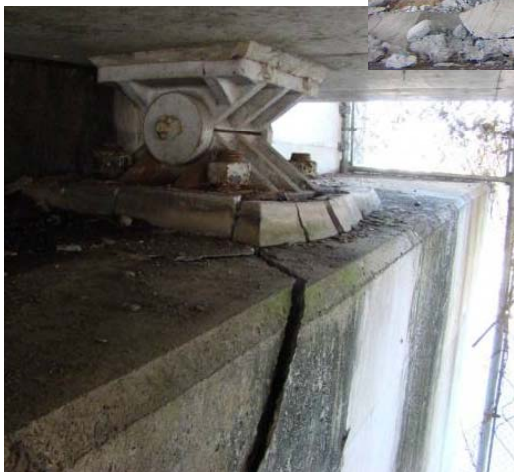
橋脚天端付近の損傷
