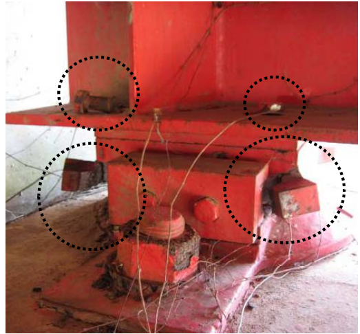
固定支承の損傷
