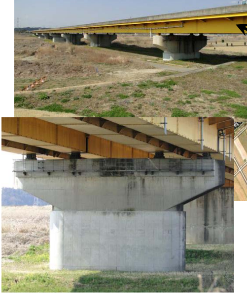
補強済みの橋 (3径間連続+4径間連続)
