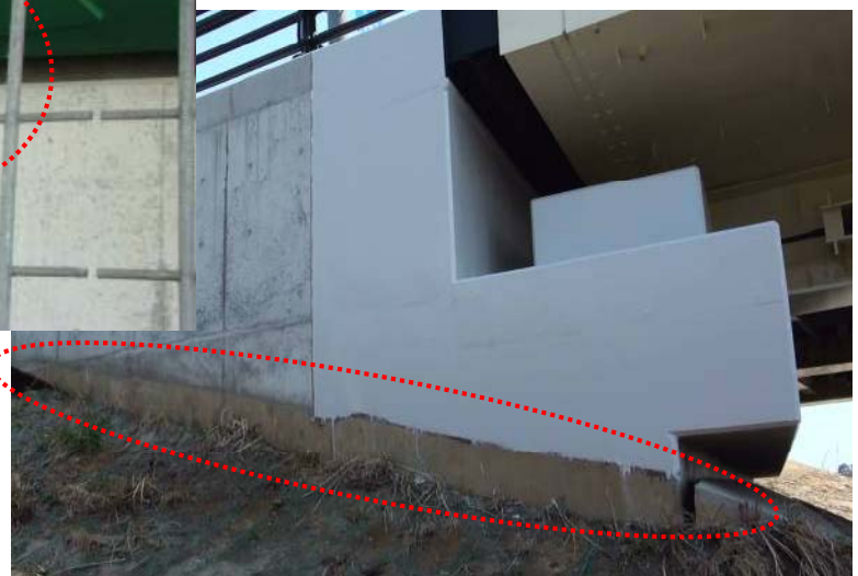
橋台背面土・周辺土の沈下
