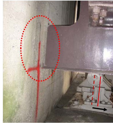
橋台部のボックスカルバートの段差
