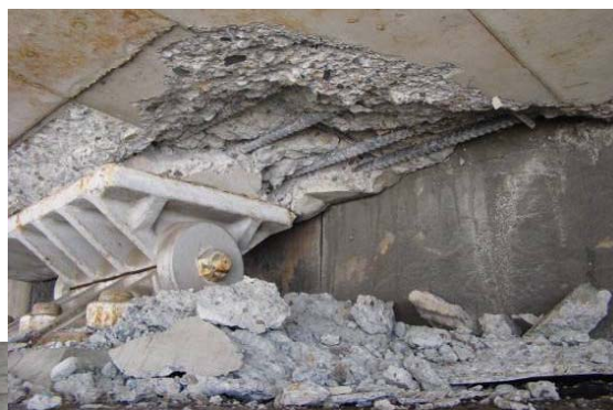
上部構造側の損傷
