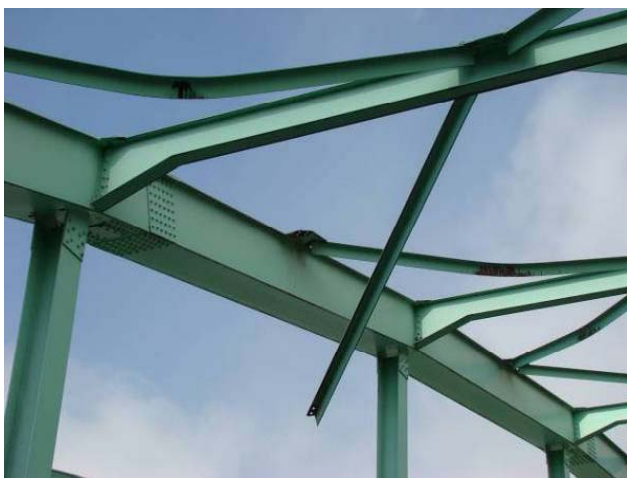
下路ランガーアーチ橋の上横構の損傷
