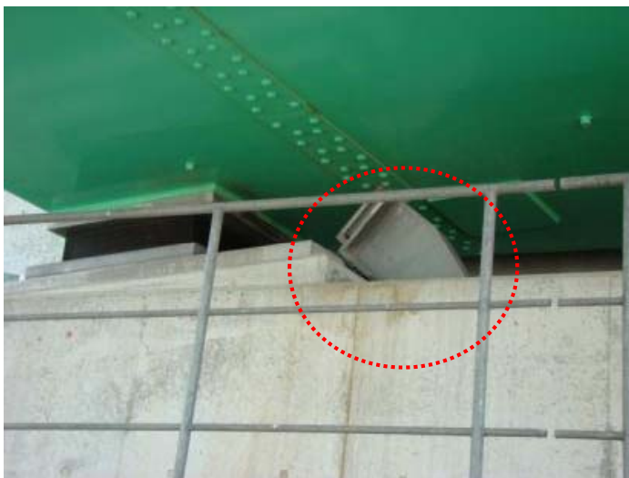
支承の変位制限をするストッパーの損傷
