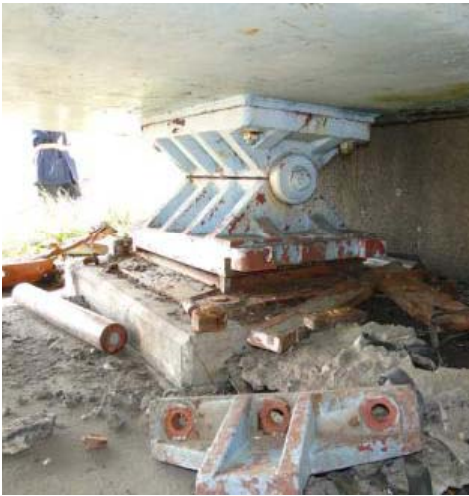
可動支承の損傷 (ローラー逸脱) と伸縮装置位置 で生じた段差
