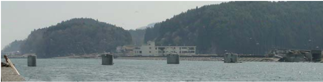
全径間の上部構造及び橋台背面土が流出した橋
