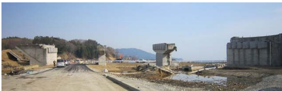
全径間の上部構造及び橋台背面土が流出した橋
