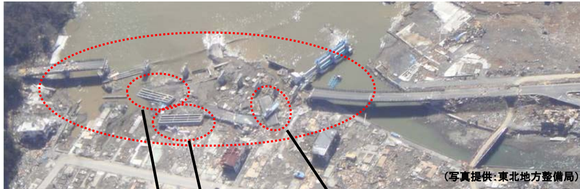
上部構造の一部径間が流出した橋
