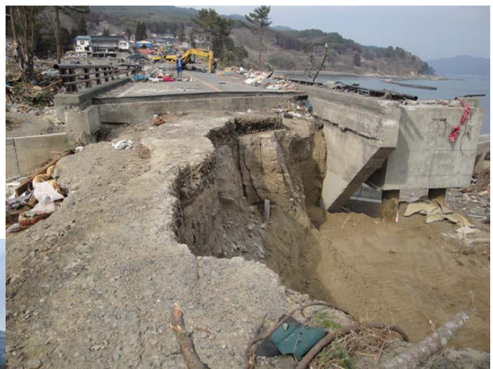
上部構造の高さに津波の遡上の痕跡があり、橋台背面土は流出したが、橋梁の構造本体は流出していない橋
