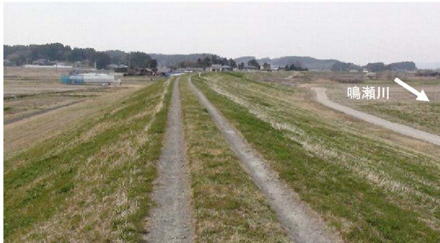
復旧した個所：変状は見られない
