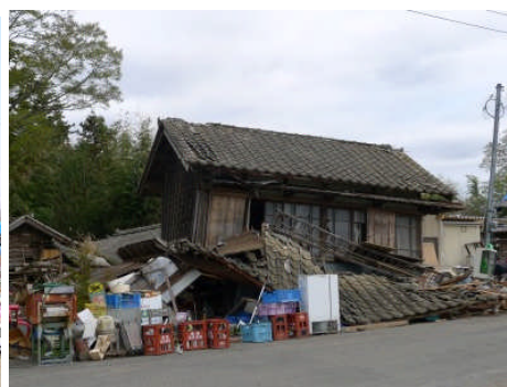
4/11の余震で倒壊 (調査は4/21)
