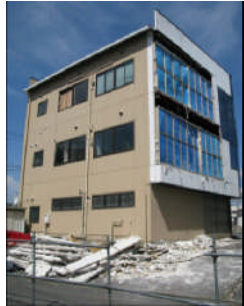
ALCパネルの脱落(白河市)
