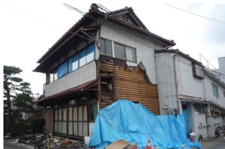
部分的に崩壊した木造
