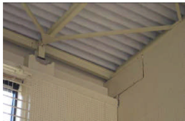
構造体との取り付け箇所で内壁が破損 (水戸市)
