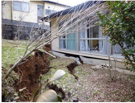
基礎が90cm程度沈下、破壊
