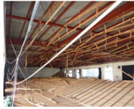
天井材の脱落
