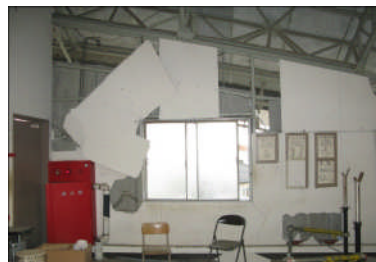
体育館の外周壁の内壁仕上材の脱落(銚田市)
