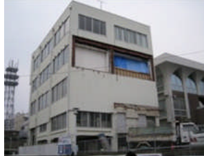
事務所の外装材の脱落
