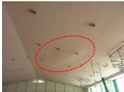
在来工法による天井面の垂れ下がり(水戸市)
