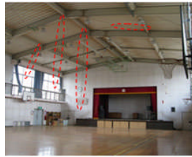
ブレース破断
