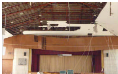
舞台上部の内壁がはらみ出している (水戸市)
