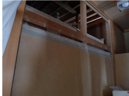
内装ボードの剥落
