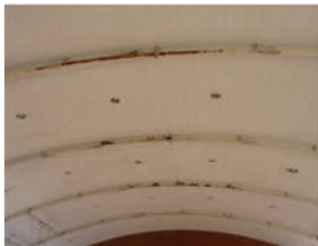
アーチ梁フランジ塗装剥がれ
