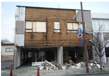
ほぼ全面的に外壁モルタルが剥落した店舗併用住宅 (倒壊したRC造の向かい)
