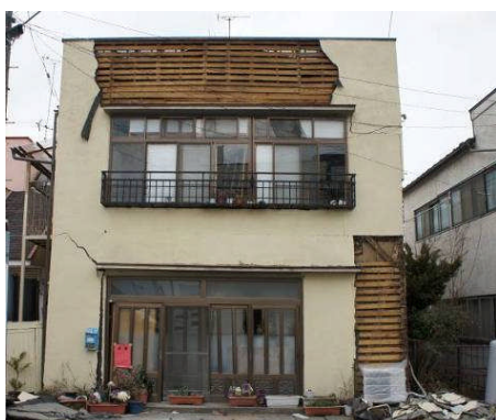
応急危険度“危険”判定の店舗併用住宅
