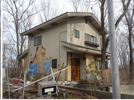
外壁モルタルの剥落
