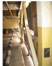
駐車場ブレースの座屈
