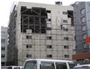
駐車場の外装材の脱落
