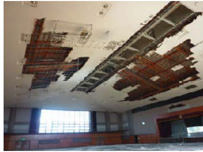
在来工法による天井の脱落(銚田市)
