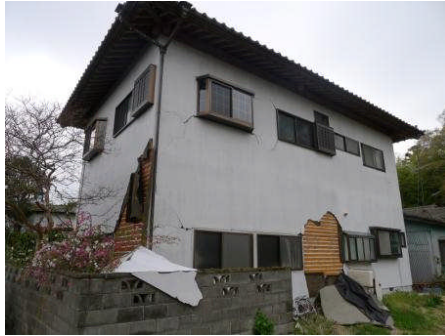
外壁モルタルの剥落
