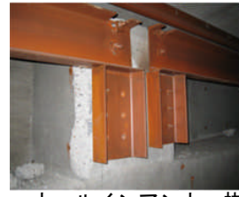
ホールインアンカー抜け出し
