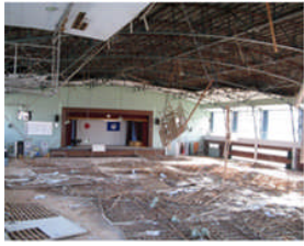
天井材の脱落
