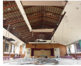
天井材の脱落
