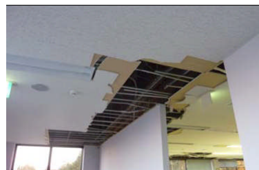
天井の下面に設置された内壁の上部において天井が破損(笠間市)
