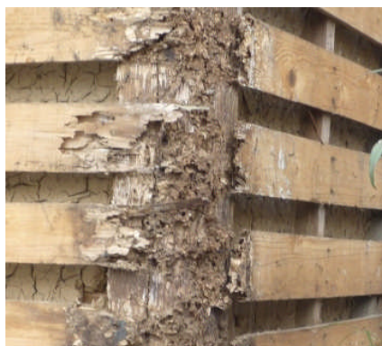
柱の腐朽とシロアリの食害
