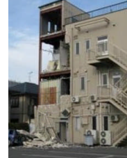
事務所の外装材の脱落
