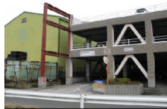
ALCパネルの脱落(仙台市)
