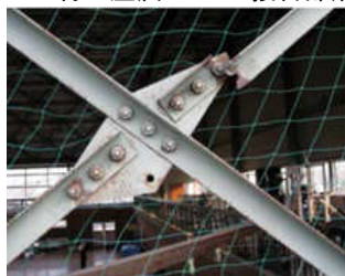
ボルト穴欠損部破断
