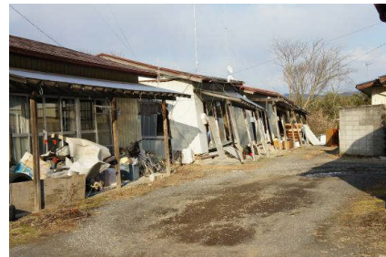
地盤変状に伴って大きく傾斜した木造住宅
