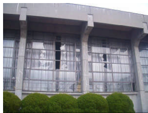
体育館のガラス破損 (郡山市)
