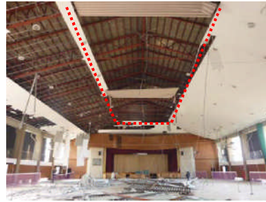
勾配箇所の在来工法による天井の破損。 水平部分(赤点線箇所)に内装材として用いられた波形の折板も脱落(水戸市)
