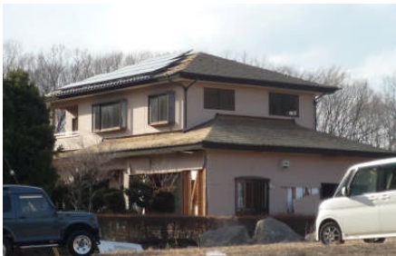
残留変形が残る木造住宅
