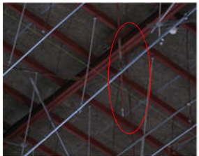
ブレース破断
