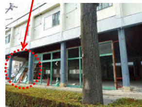
ガラスの破損およびサッシ枠 の脱落(郡山市)
