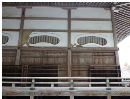
漆喰塗りの一部が剥落
