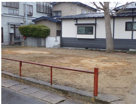
液状化による噴砂痕
