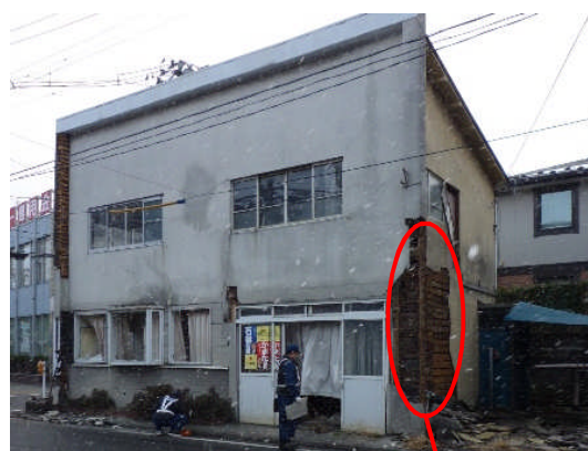
モルタル外壁の剥落
