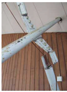
接合部溶接部破断
