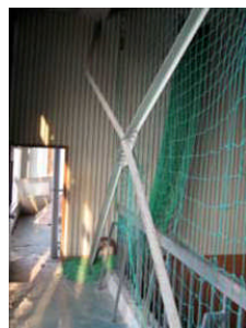
ブレース材の座屈
