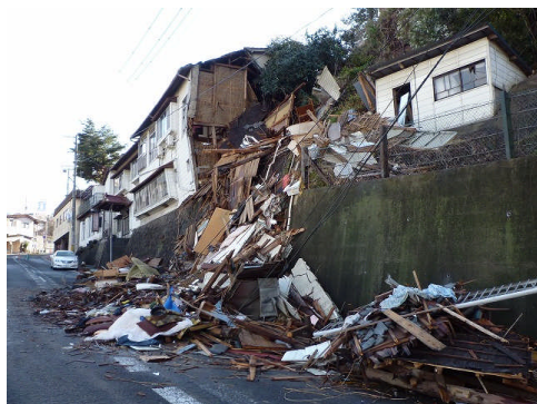
裏山の崩落により、倒壊・転落
