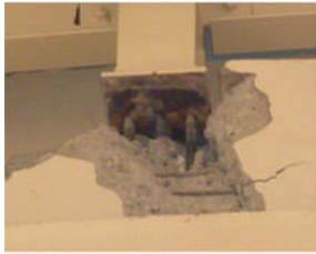
コンクリート剥落
