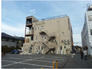
ALCパネルの脱落(郡山市)
