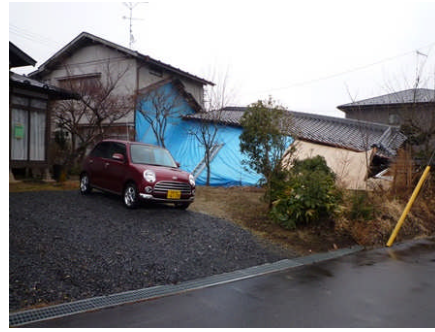
倒壊した家屋
