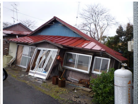
地盤変状に伴う住宅の被害
