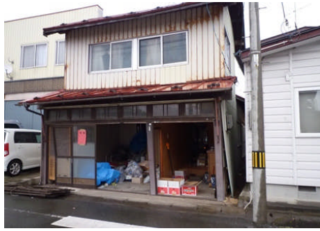
店舗併用住宅の被害
