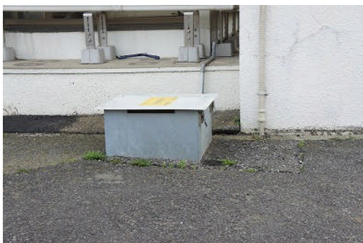
写真 1 龍ヶ崎市震度計設置状況
