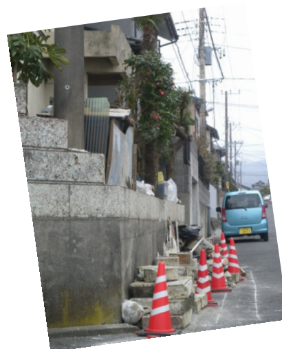
写真10 倒壊した塀 2
