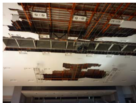
写真 17 天井の脱落 2
