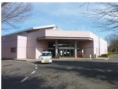
写真 15 B 体育館の外観
