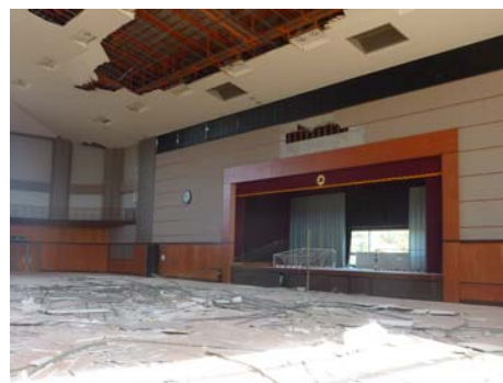
写真 17 天井の脱落 2
