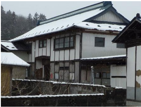
写真 29 長屋門の土塗り壁剥落 (栗原市栗駒桜田)
