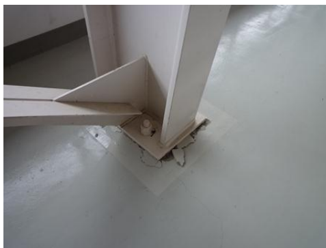
写真 34 写真 31 の鉄骨柱脚部の損傷 (栗原市栗駒)
