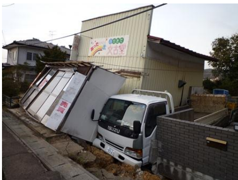
写真 6 地盤変状に伴う住宅被害 (青葉区折立 5 丁目)
