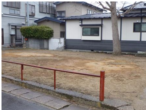
写真 12 液状化による噴砂の痕跡
