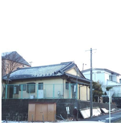
写真 48 棟瓦落下および塀の倒壊 (仙台市青葉区旭ヶ丘)
