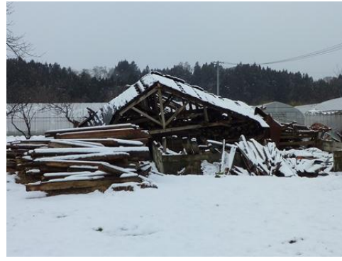
写真 28 木材小屋の倒壊 (栗原市栗駒桜田)
