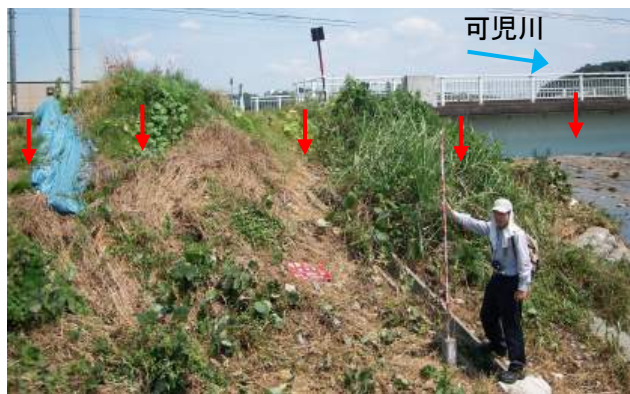
写真3 戸走橋直下流越流部 (越流水深約 2.2m)
