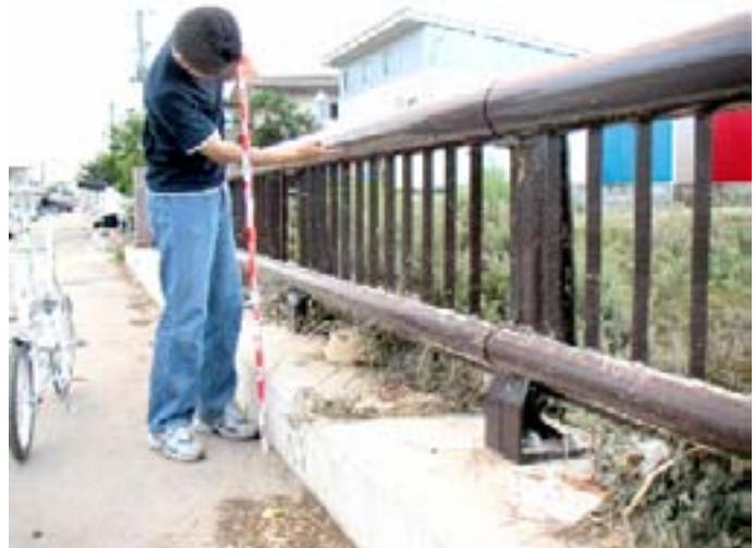
写真－３ 高欄の痕跡（地区４）
