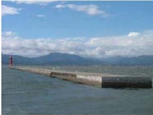
被災前の状況
