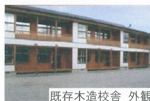
既存木造校舎 外観
