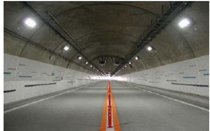
トンネル照明等に電力を供給
