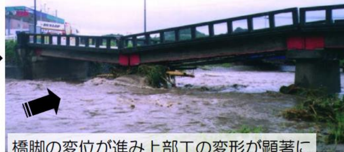
④ 橋脚の傾斜進行、桁の折れ曲がり
