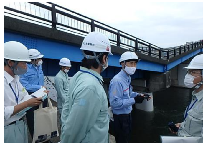
令和3年7月6日派遣 豪雨による洗掘被害を受けた 黄瀬川大橋に対し技術支援を実施
