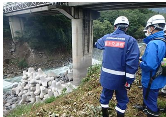
令和3年8月21日 大雨による洗掘被害を受けた 新大田切橋に対し技術支援を実施
