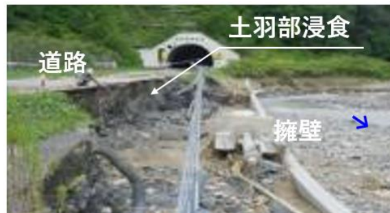
IV：護岸天端からの侵食による被災
