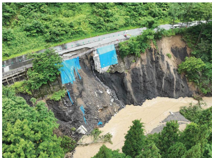
令和4年8月8日派遣 豪雨により斜面が洗掘被害を受けた 道路崩壊に対し技術支援を実施
