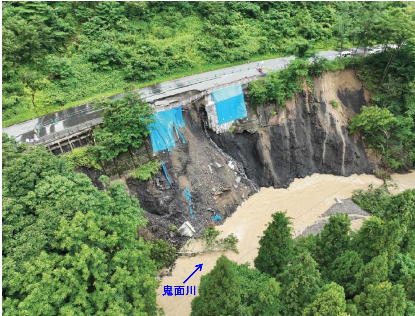
国道121号(山形県米沢市)
