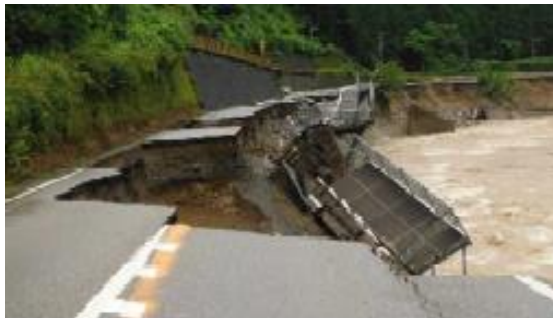
I：河床洗掘による被災
