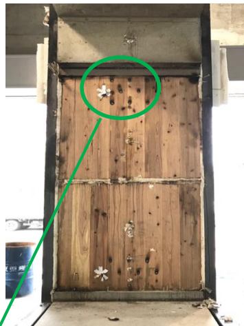
非加熱側状況※
