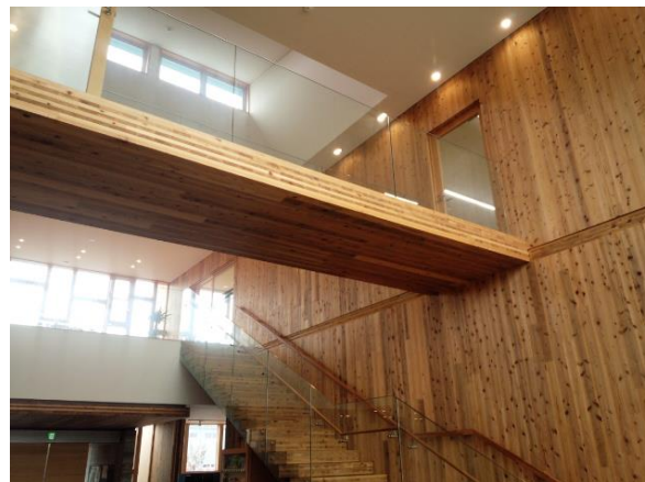
中層建築物において構造部材である木材をそのまま見せる設計
