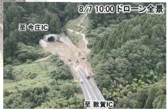
国道8号および北陸道の被災状況（福井県南越前町）
