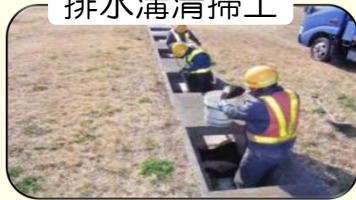
排水溝清掃工
