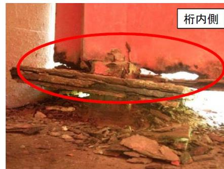
桁内側からの近接目視により断面欠損を確認
