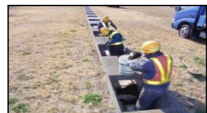
排水溝清掃工 (土砂堆積量)
