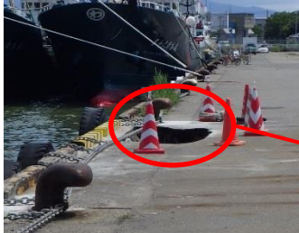
岸壁エプロン陥没 長さ4.7m × 幅1.9m × 深さ1.5m
