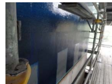
繊維シート貼付 熊本地震の復旧で適用した補修工種例
