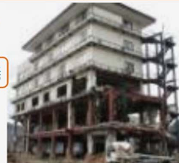
津波による外装材流出事例(宮古市)
