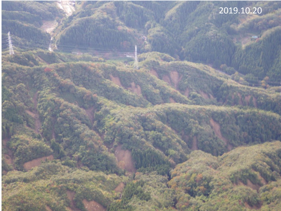
東向き斜面を中心に表層崩壊が多発(五福谷川)
