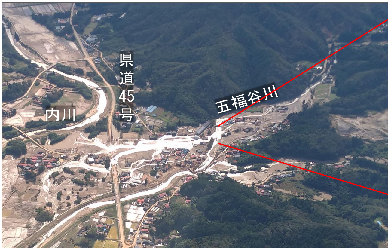
五福谷川下流域の状況(宮城県伊具郡丸森町)(10月17日)
