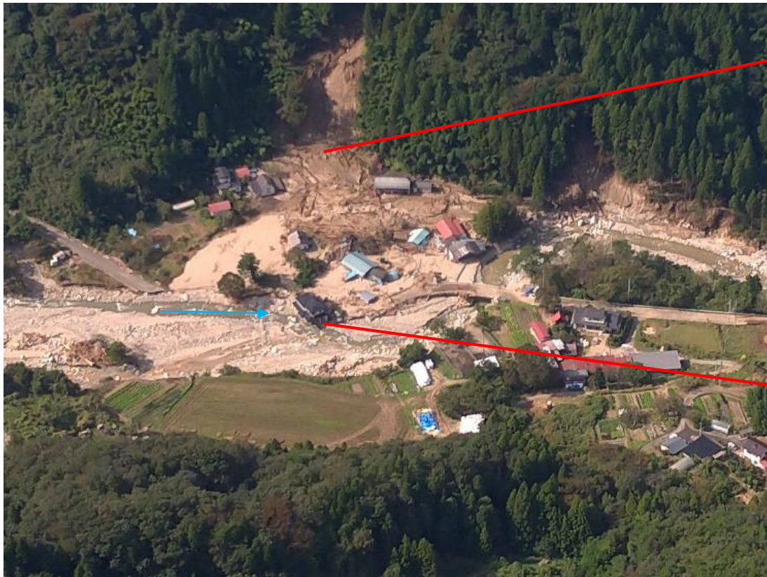
土砂・洪水氾濫と土石流により被災した薄平地区の状況 (10月17日)
