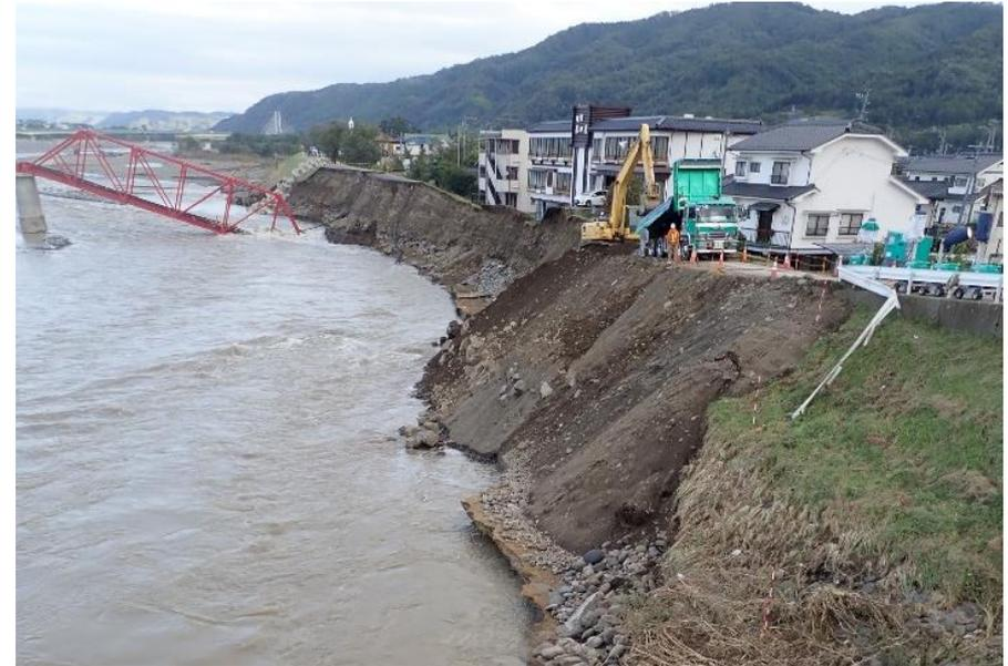
千曲川左岸付近の堤防決壊箇所被災状況
