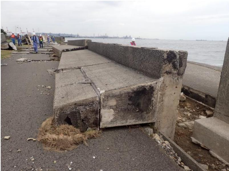
横浜港本牧ふ頭地区における護岸上部工の倒壊
