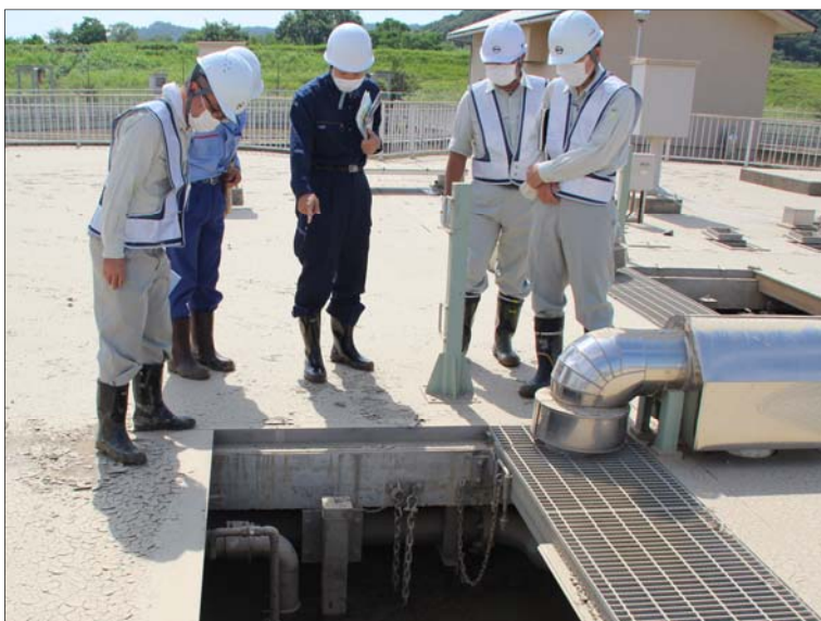
浸水した水処理施設の被害状況を確認する 国総研職員(7月11日)
