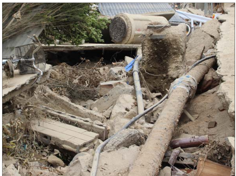
下水管の流失箇所 (写真中央上:被災したマンホール、7月11日)
