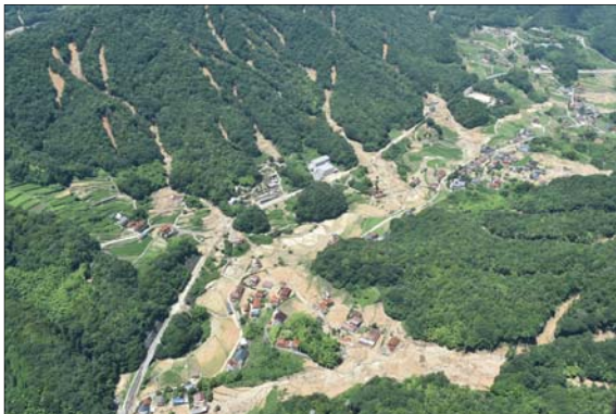
土砂災害現場の状況(7月10日)
