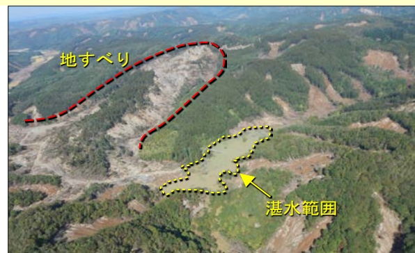
地震に伴う地すべりにより生じた大規模な河道閉塞（閉塞高さ約50m）
