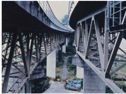
東名高速道路、上路トラス 主構トラス上弦材と床トラスの接合部 設計では単純支持。フランジ間をつなげた ディテールの橋もあり。亀裂の発生はなし。
