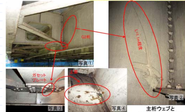
主桁ウェブと面外ガセットの継手 面外ガセットの継手
