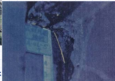
東名高速道路、上路トラス 主構トラス上弦材と床トラスの接合部 設計では単純支持。フランジ間をつなげた ディテールの橋もあり。亀裂の発生はなし。
