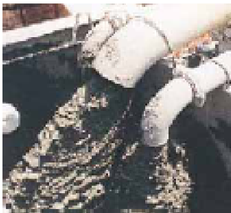
〔汚泥発生工事〕
