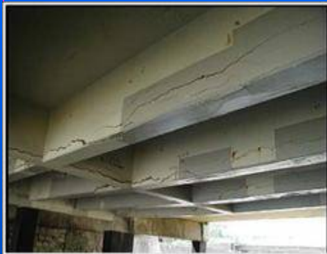
【塩害による再劣化事例】
