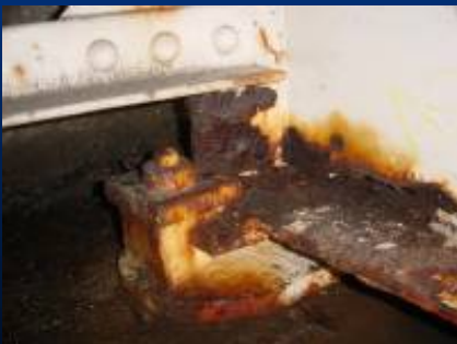
桁端部の損傷例
