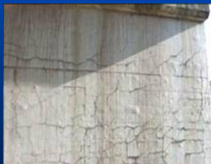
【アルカリ骨材反応による再劣化事例】
