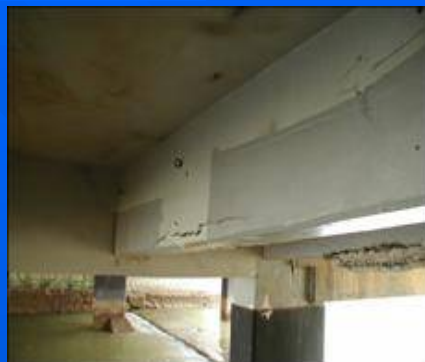
【塩害による再劣化事例】
