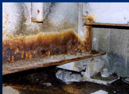
桁端部の損傷例
