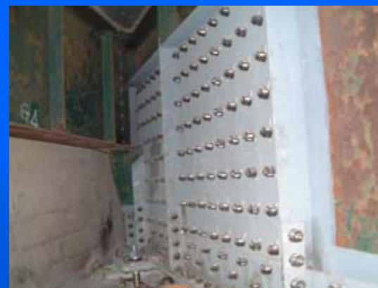
桁端部の補強
