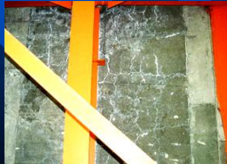
端部床版の損傷例
