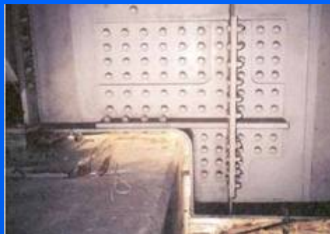
桁切欠き部の補強
