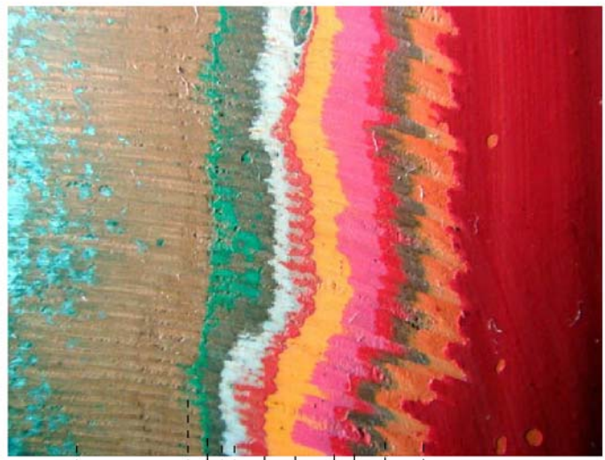
(素地調整部分の塗装境界)
