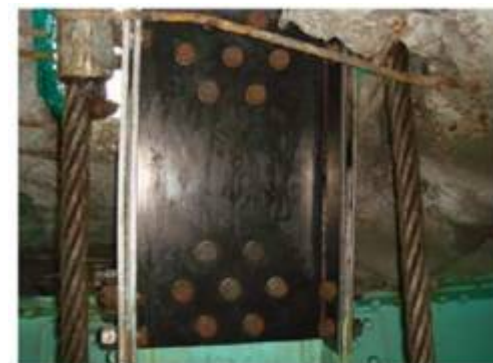
破断箇所の応急復旧
