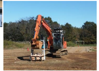
【建設機械屋外実験場】予約制イベント 建設機械屋外実験場に設置した無人ショベルの 操作体験と見学を行いました。
