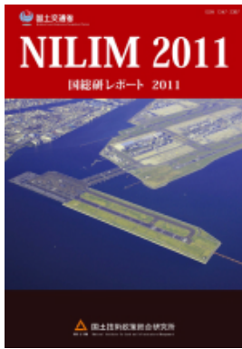
2010年10月に供用開始された羽田空港D滑走路
