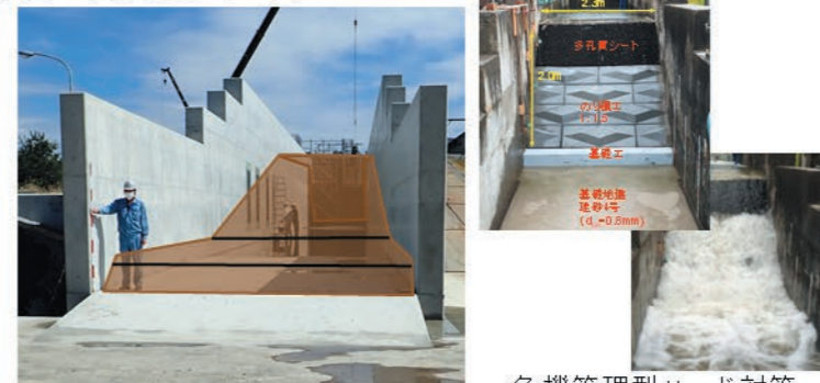
実大スケールの堤防模型設置イメージ 危機管理型ハード対策に関する実験の様子
