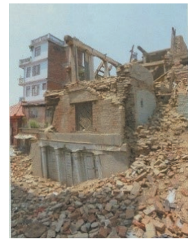
図-10 ネパール地震における被害状況
